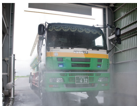
車両消毒設備
