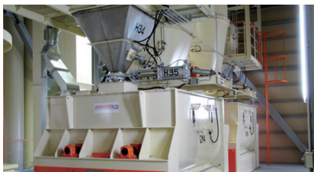
主配合混合設備（ツインバドルミキサー）
