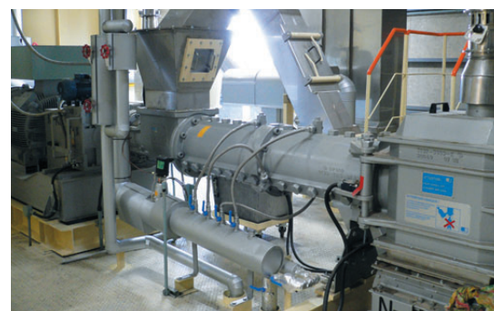
熱処理加工設備（エクスペンダー）
