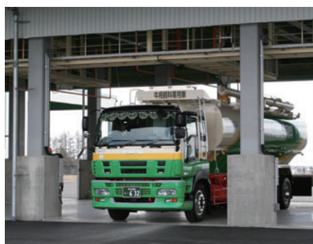
バラ製品タンク出荷設備
