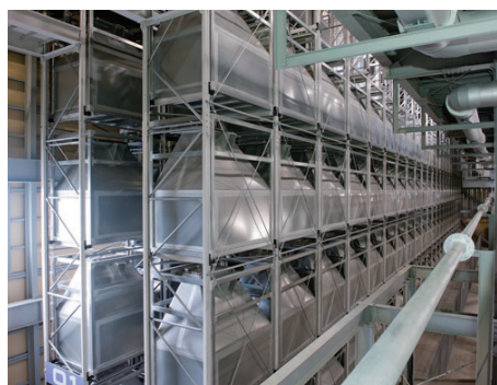
小口出荷設備
